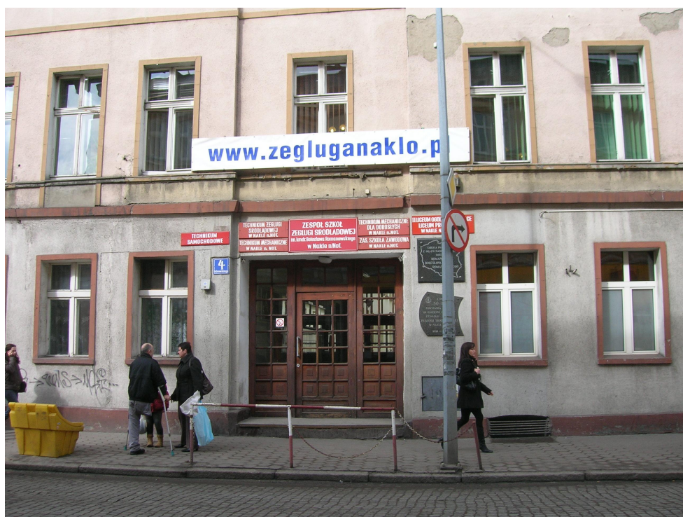
Fot. 2. Elewacja frontowa – drzwi wejściowe
